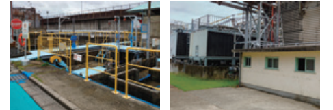
京都工場に設置のクーリングタワーと清水池
